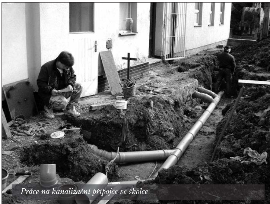
I takhle umělecky může vypadat oddělení splaškových a dešťových vod
