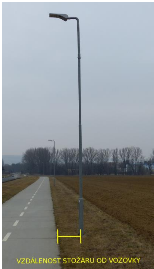
Obr. 2: Určování rozměrů světelného bodu – vzdálenost stožáru od vozovky
